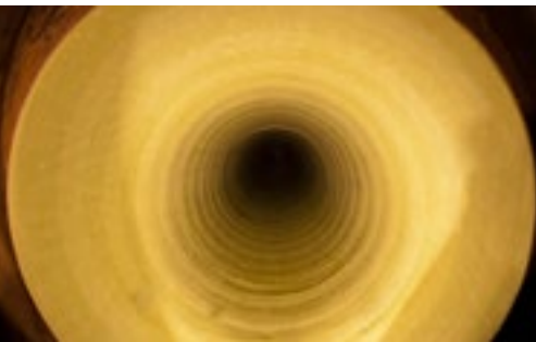
Schlauchliner im Kanal
