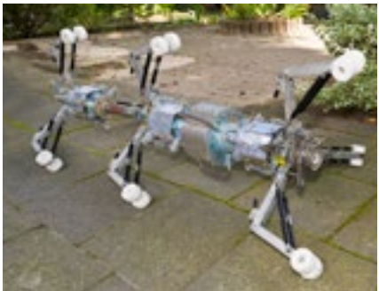
Lichterkette zur Schlauchlineraushärtung mittels UV-Licht
